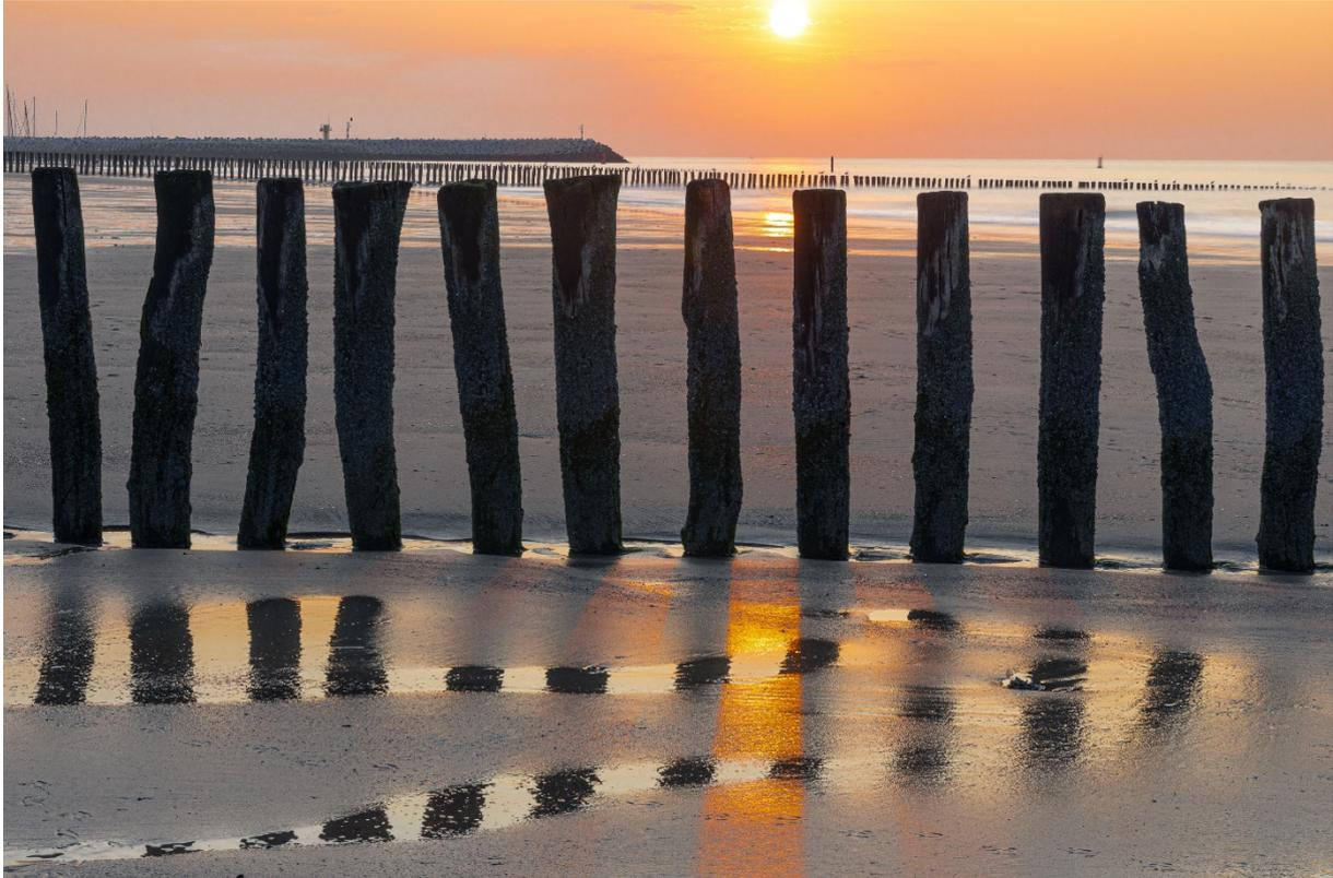
Buhnen sind Reihen aus Holzpfählen. Sie schützen die Küste. Die Pfähle stehen dicht zusammen aber mit Abstand. Die Buhnen verringern damit die Kraft von den Wellen. Dadurch wird weniger Sand von der Küste ins Meer weggespült.
